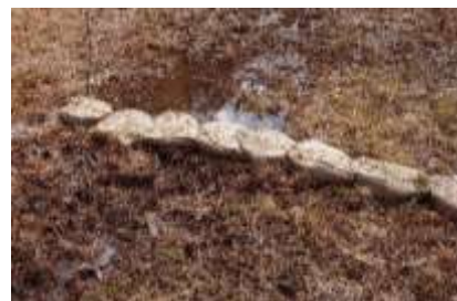
3/9 土嚢による水路埋め戻し
