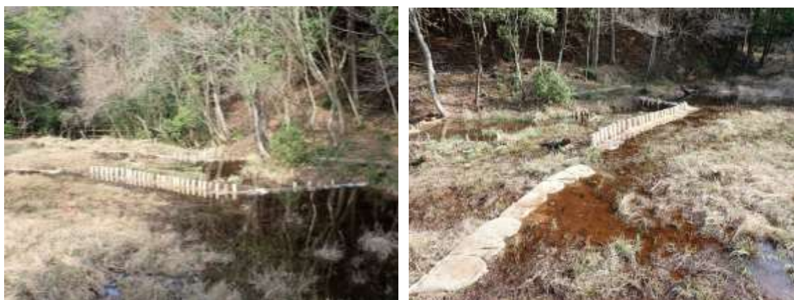
下池下流部の土嚢堰の補修、追加工事
